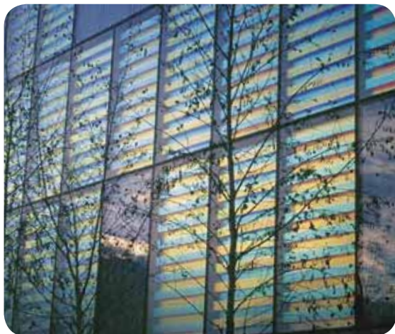
Des lamelles de film plastique réfléchissant la lumière sont placées entre les verres et forment un élément décoratif.
