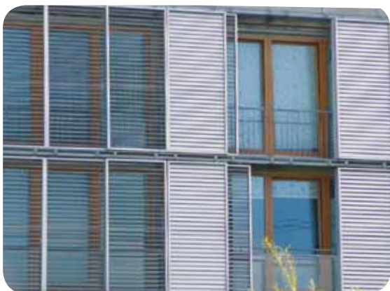
Ces stores déplaçables latéralement évitent la surchauffe et empêchent les collisions des oiseaux.
