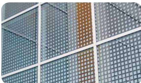
Trame dont le taux de couverture diminue progressivement vers le haut. Efficace s'il n'y a pas de grands arbres à proximité.
