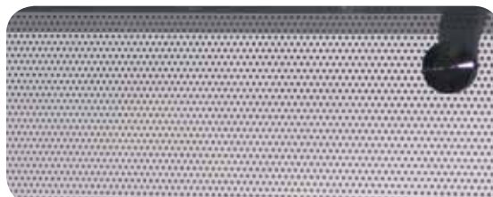
Exemple d'une telle trame imprimée sur un toit en verre.
