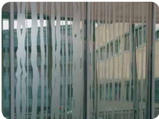
Ce décor de lignes mates («crystal») a obtenu de bons résultats lors de tests.
